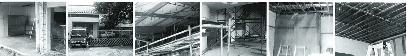
耐震工事実施中<たいち作業棟・おおぞら B>
