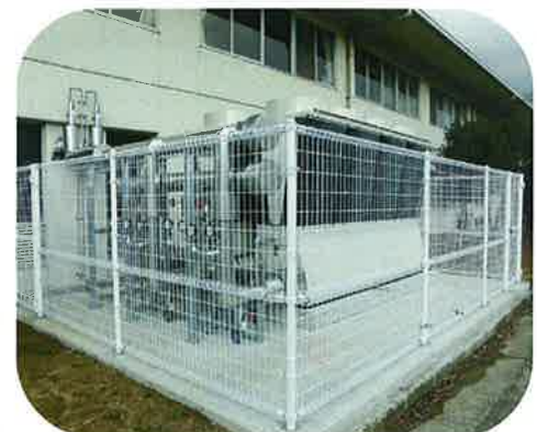
管理教育棟の空調熱源改修工事が、 12月に終わりました。
