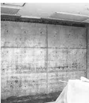
▶ 本館内部耐震工事
